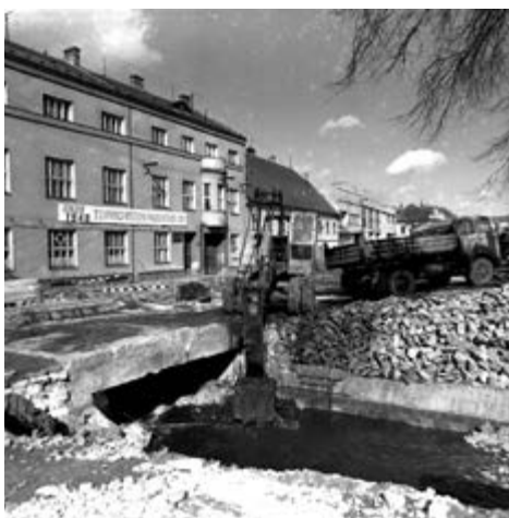
Stavba průtahu středem města
