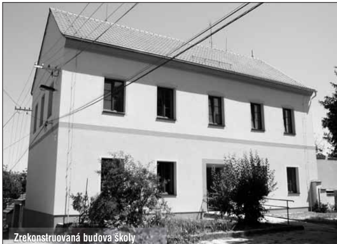
Zrekonstruovaná budova školy
