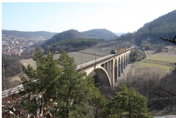
Obrázek 1 Rekonstrukce koleje č. 2 v km 30,650 - 38,616 tratě Brno - Havlíčkův Brod
